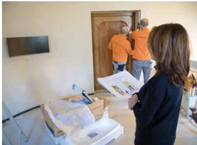
Una fase dei lavori di allestimento in Sala Clima (GD).
