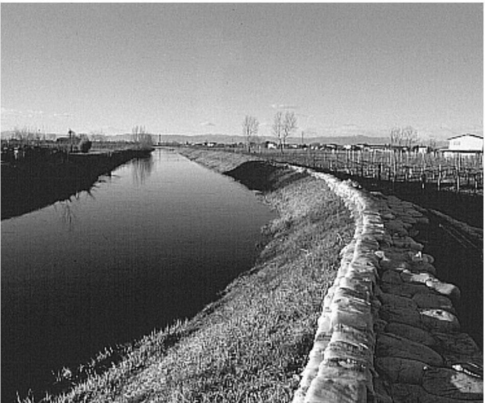
Fig. 4. – Il volto attuale della Tergola a Pionca, rettificata e chiusa in strette arginature, con i segni di un recente intervento per scongiurare l'ennesima tracimazione (foto M. Varotto, 1999).
