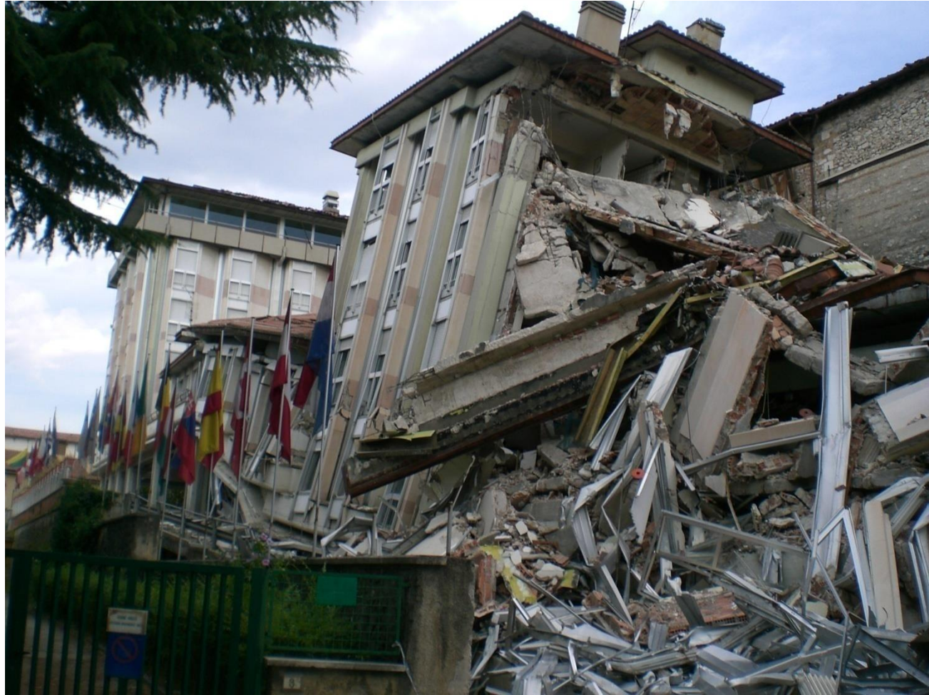
L'Aquila: seismic effect on the Duca degli Abruzzi hotel
