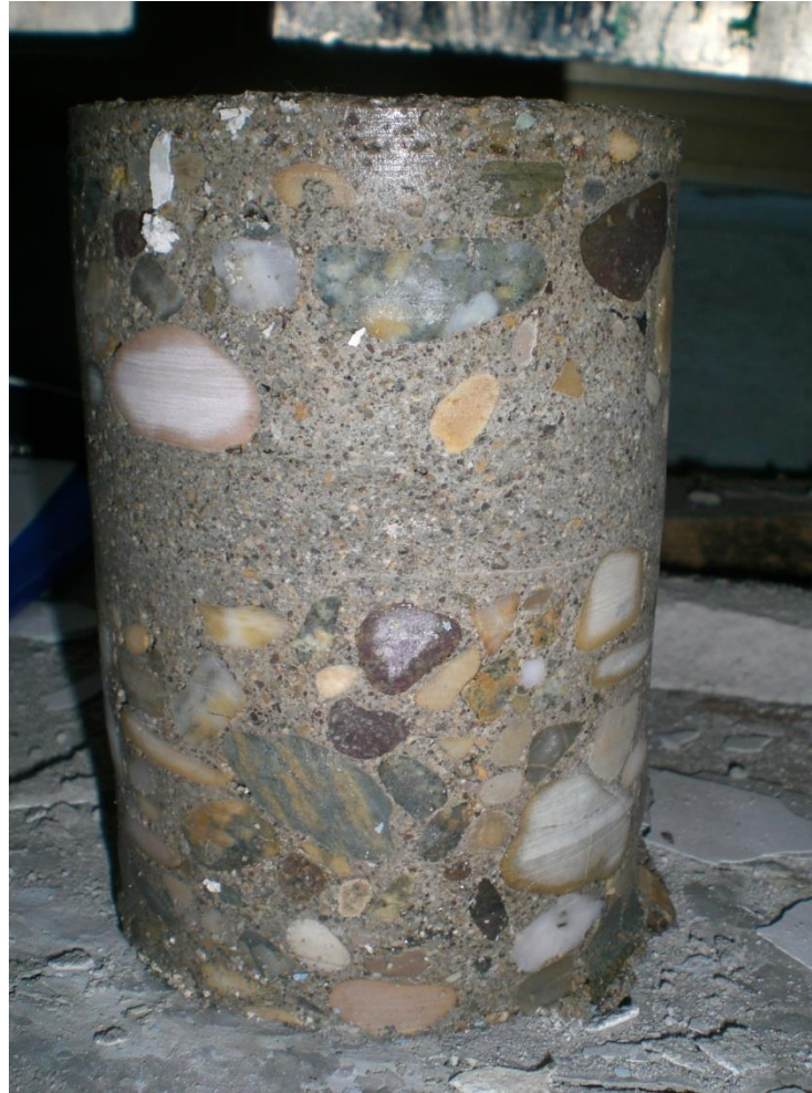
Castello di Padova, first floor slab
