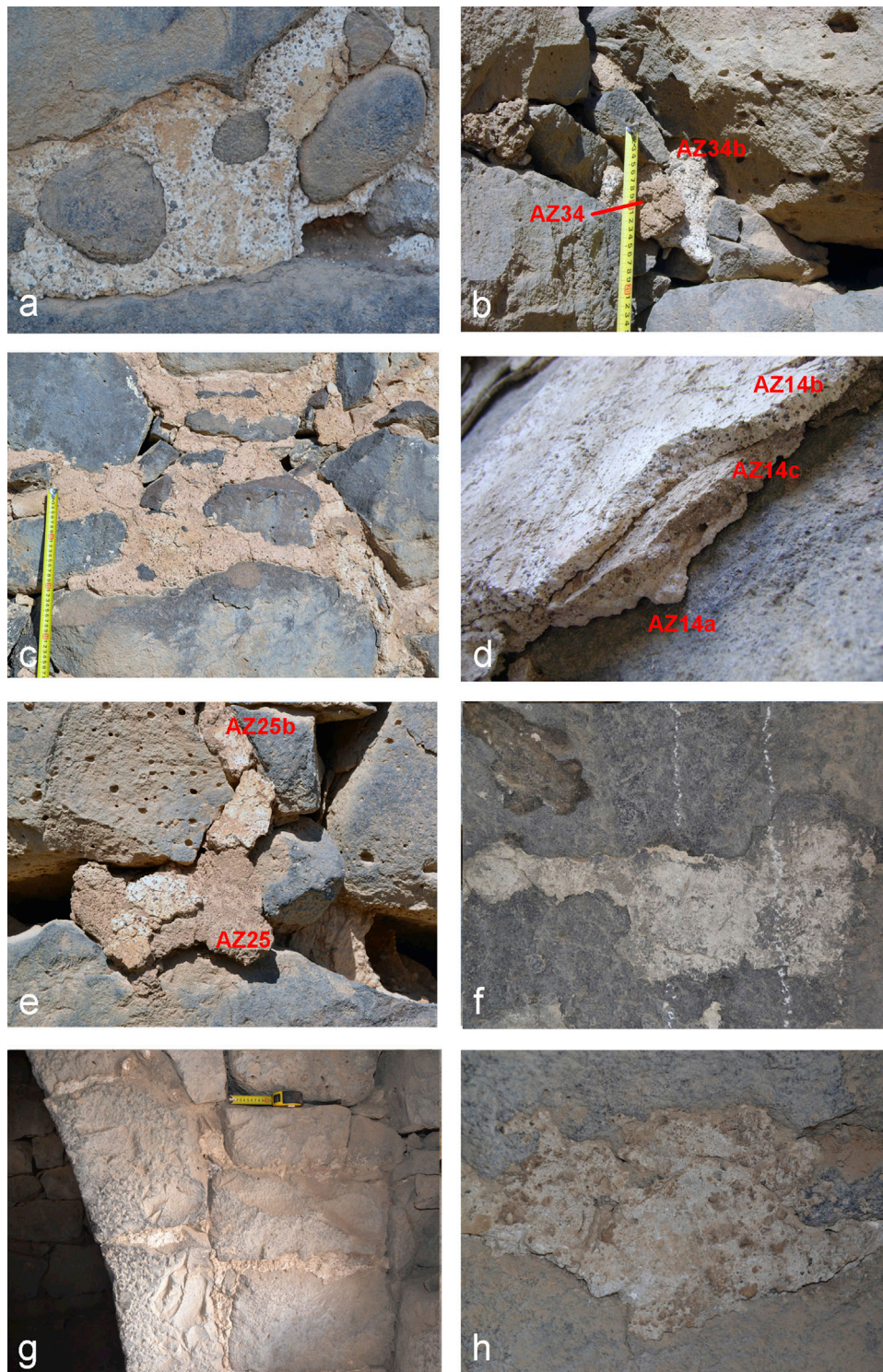
Fig. 4. a. Sampled mortars: a: mortar A1 (AZ33); b: mortars A1 (AZ34b) and B (AZ34); c: mortar A2 (AZ22); d: mortars A2 (AZ14b), C (AZ14c), B (AZ14b); e: mortars A2 (AZ25b) and C (AZ25); f: mortar E1 (AZ44); g–h: mortar E2 (AZ45); b: sampled mortars: a: mortar B (AZ09); b: mortar B (AZ28); c: mortar C (AZ31); d: mortar C (AZ31 covered by AZ31lw); e: mortar C (AZ26); f: mortar D1 (AZ02); g: mortar D2 (AZ03); h: mortar outlier (AZ10).
