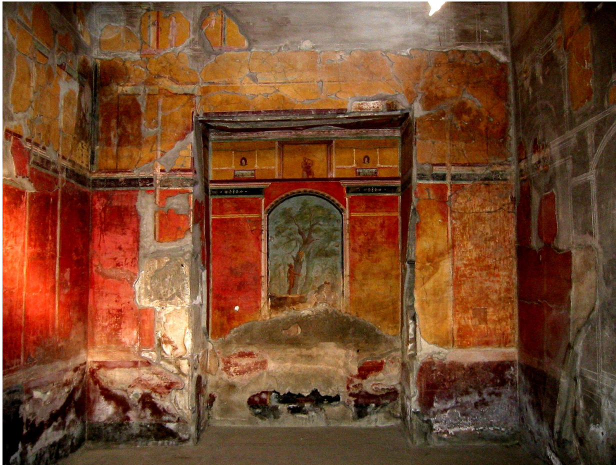
Oplontis, Villa di Poppea (I secolo d.C.)
