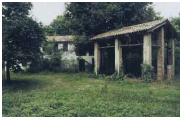
Fig. 13 - Il rudere della presa XII nella fotografia allegata alla scheda di rilevamento (n° 174/1) presente nel Piano di Settore (1993).
