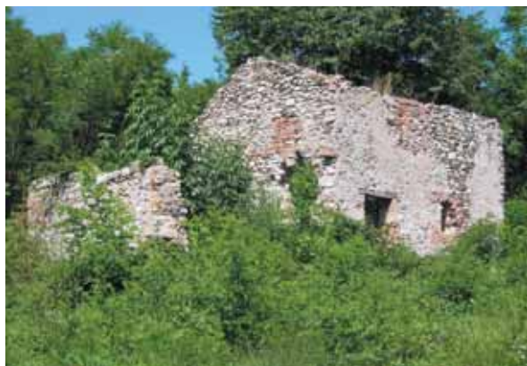
Fig. 11 - Il rudere tra la presa XVI e la presa XVII (Foto M. Modesto).
