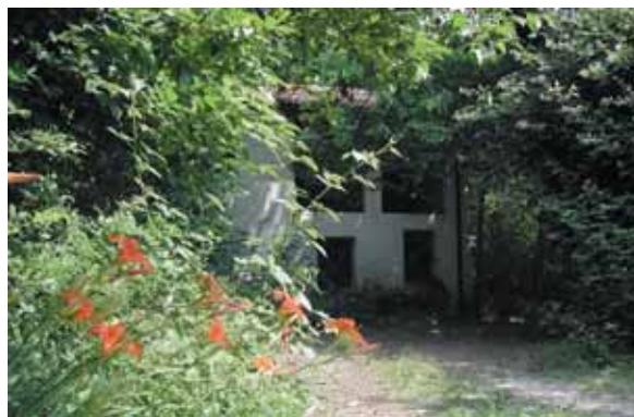
Fig. 14 - Il rudere della presa XII (fotografia scattata nel giugno del 2005).
