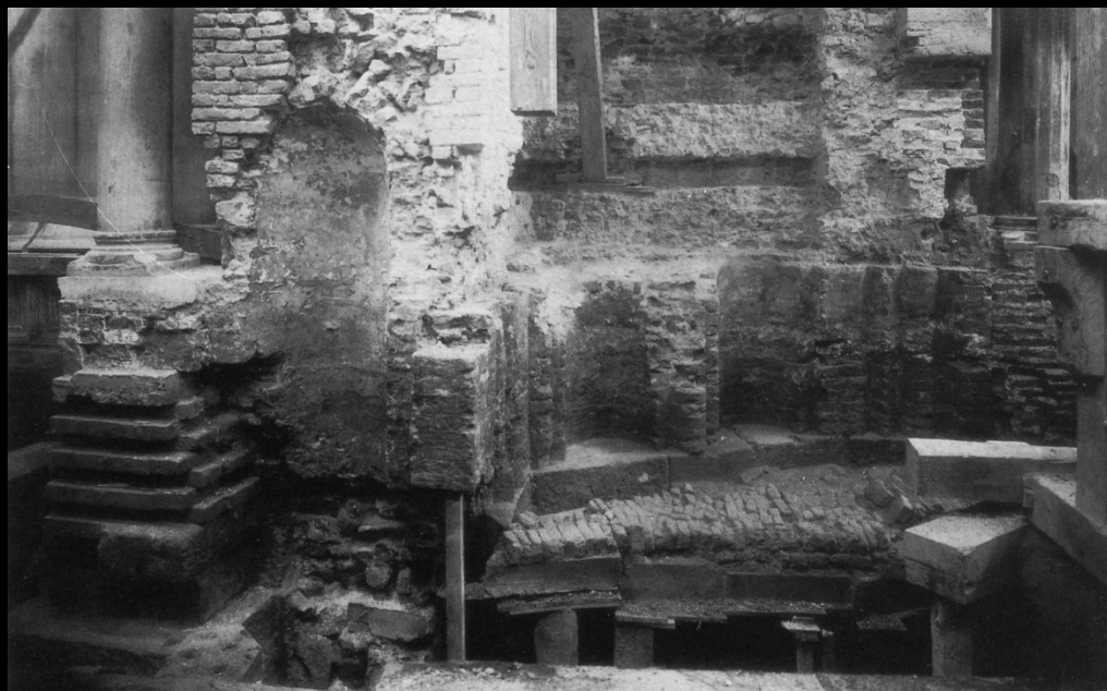
13. Resti dell'originaria stesura in laterizio al di sotto del rivestimento marmoreo, angolo di Sant'Alipio. Venezia, Basilica di San Marco (Foto Procuratoria di San Marco, Venezia).
