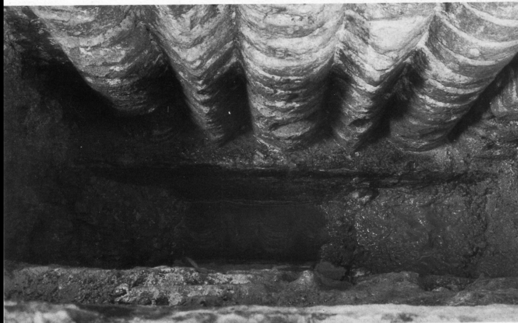
14. Basamento del secondo pilastro della facciata al di sotto del rivestimento marmoreo, particolare Venezia, Basilica di San Marco (Foto Procuratoria di San Marco, Venezia).
