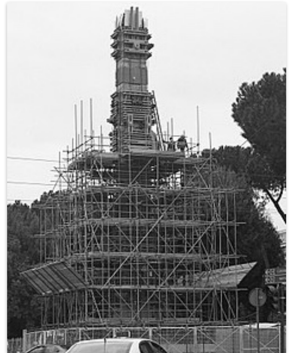
Le impalcature per lo smontaggio della stele, riportata in Etiopia (2005-2008)
