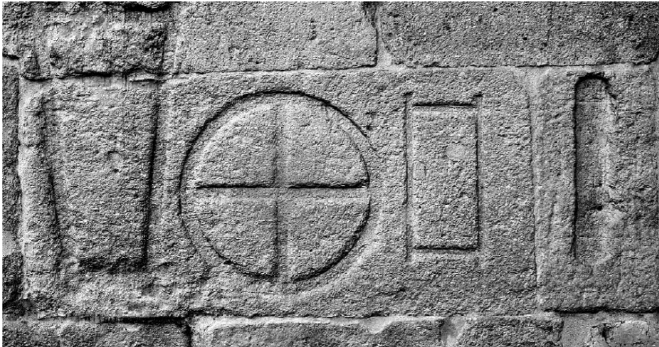
Modello del coppo, del mattone da colonna, del mattone e del brazzolaro (volto della Corda, Palazzo della Ragione, Padova)
