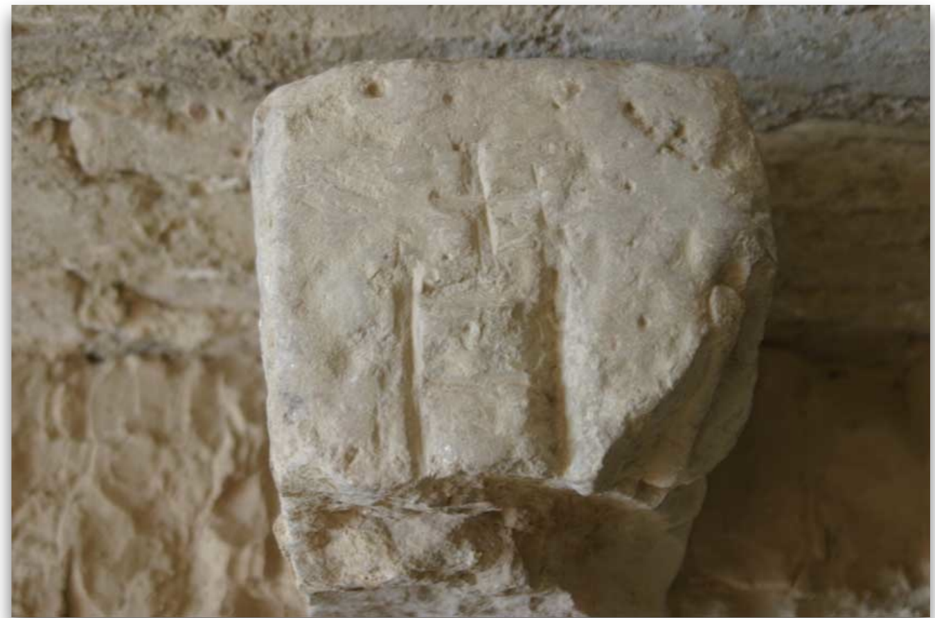
Siena, Santa Maria della Scala, pietra semilavorata in cava con il simbolo della scala ('marchio' di proprietà)
