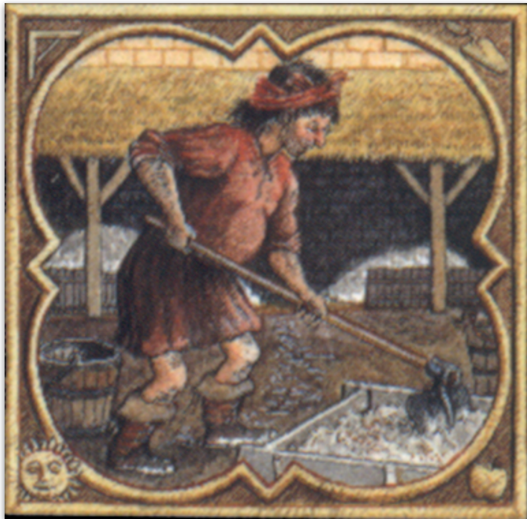
Il calcinaio, o maltatore, prepara la malta nella masta
