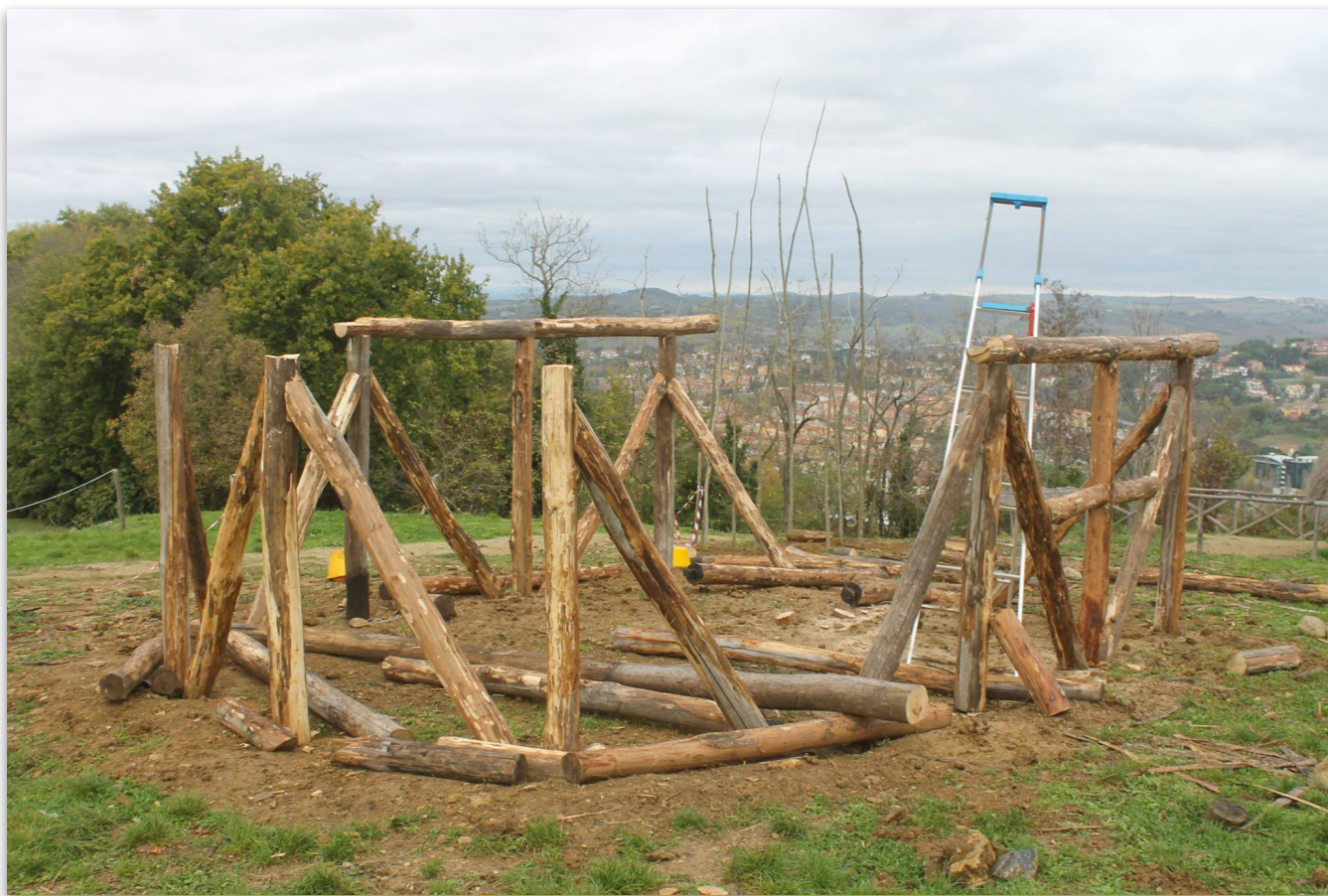
Il posizionamento dei pali per la costruzione delle pareti
