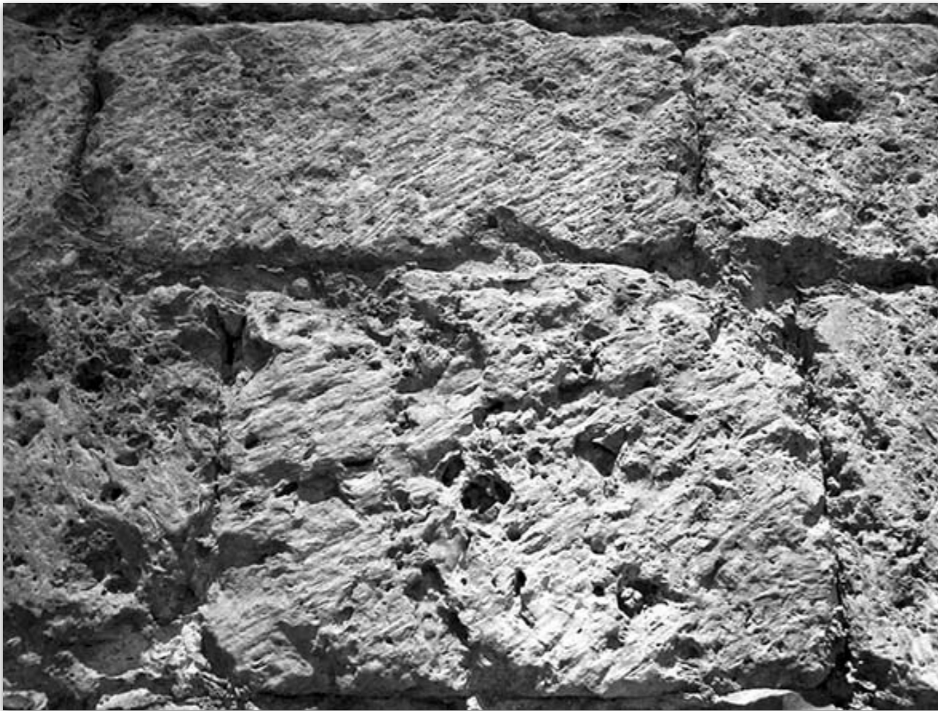
Tracce di lavorazione: strumenti a lama liscia (martellina a lama liscia/ascettino)
