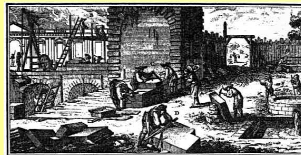
Un cantiere del XVIII secolo, dall'Encyclopédie di Diderot e d'Alembert
