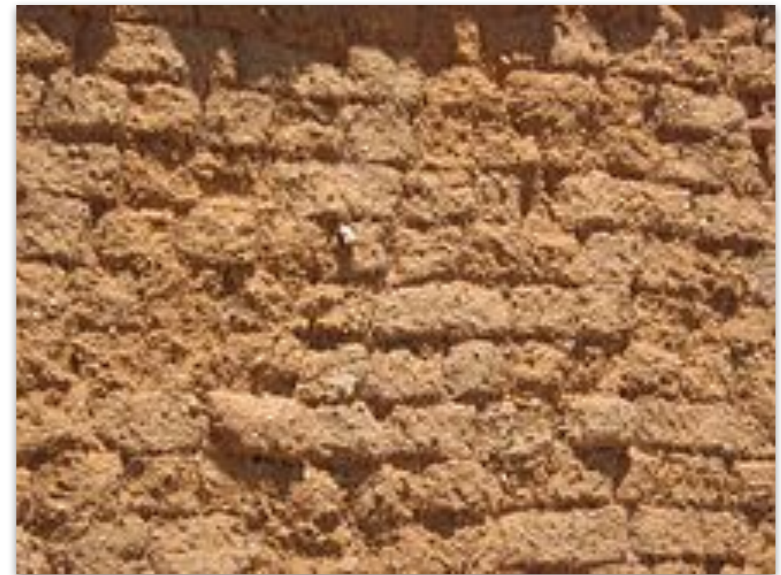
Muratura in adobe
