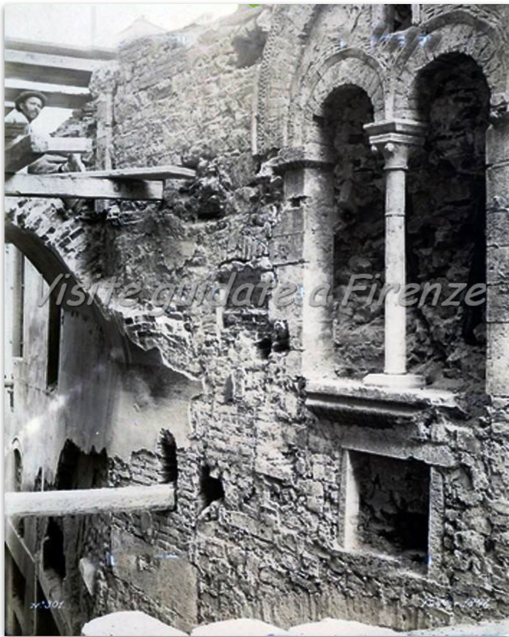
Anni '60 del XIX secolo: demolizione del palazzo dell'Arcivescovado
