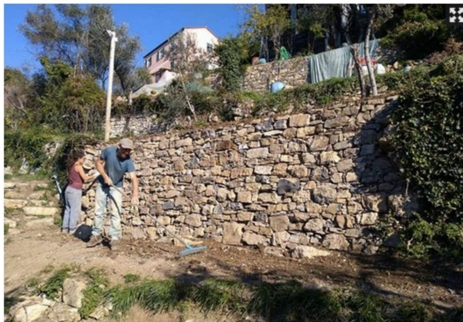
Un muro in costruzione sul promontorio di Portofino
