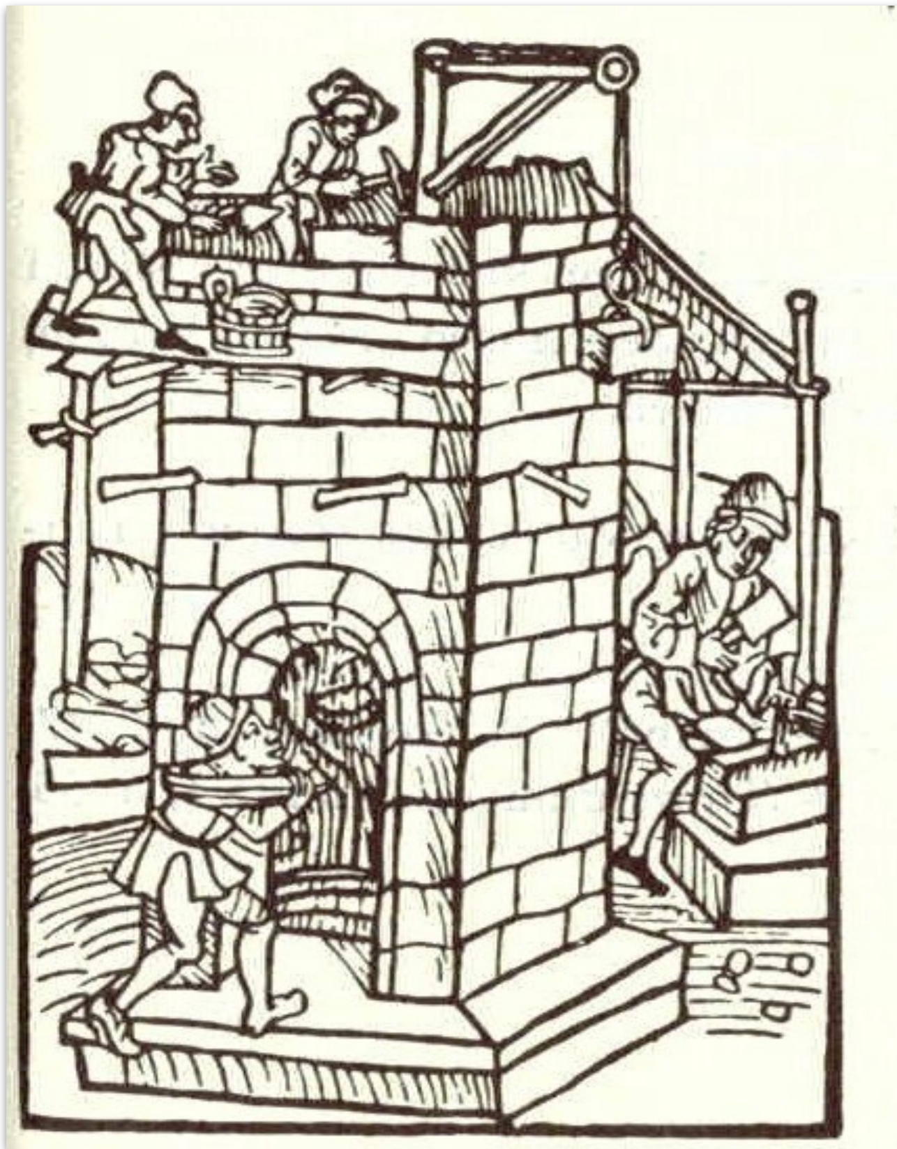
Scena di cantiere con la costruzione di una loggia appoggiata alla fabbrica, dalla raccolta di Peter Drach, Spira, 1479
