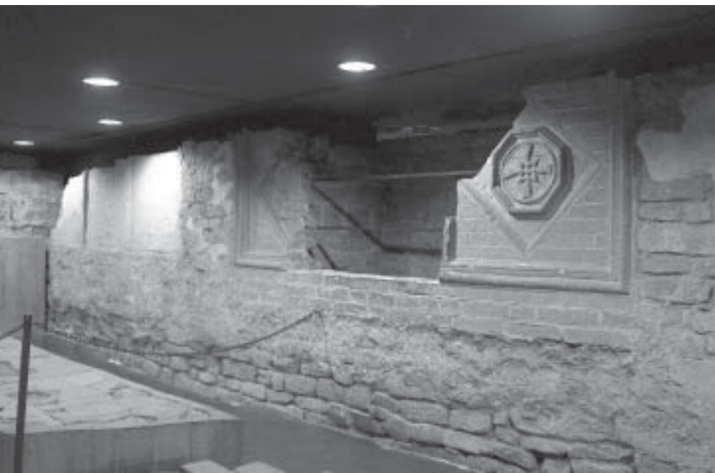
Il muro meridionale di S. Reparata nel suo lato interno, con la successione di fasi murarie e di avelli
