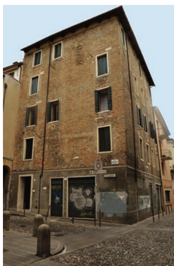
Fig. 6. Casa-torre in via Gritti.
