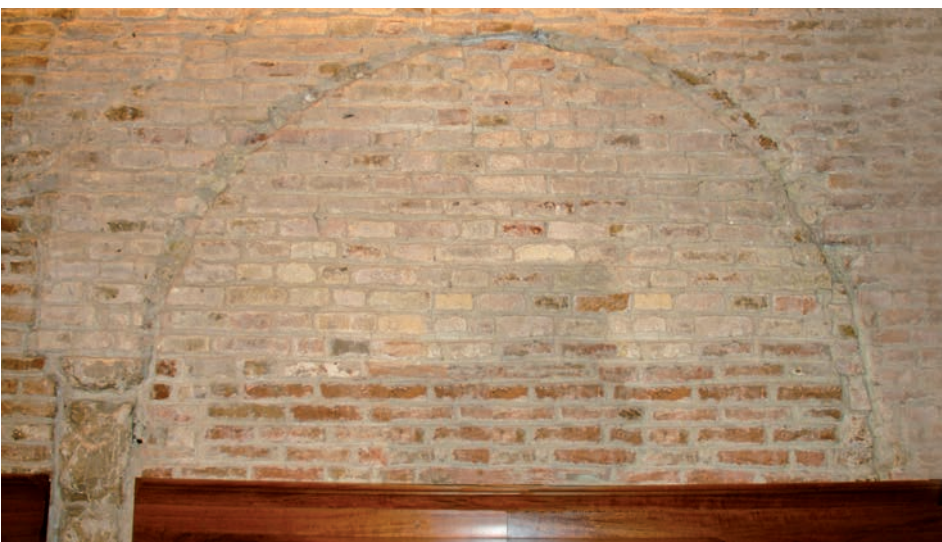
Figg. 35-37. Traccia del portico dei canonici nei prospetti del battistero e dell'edificio che si trova sul lato nord dell'attuale cortile.
