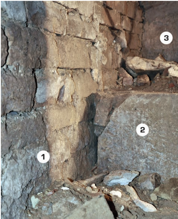
Fig. 16. Santa Sofia, lato sud della cripta: muro dell'emiciclo (1) cui si appoggia la fondazione della cripta (2).
