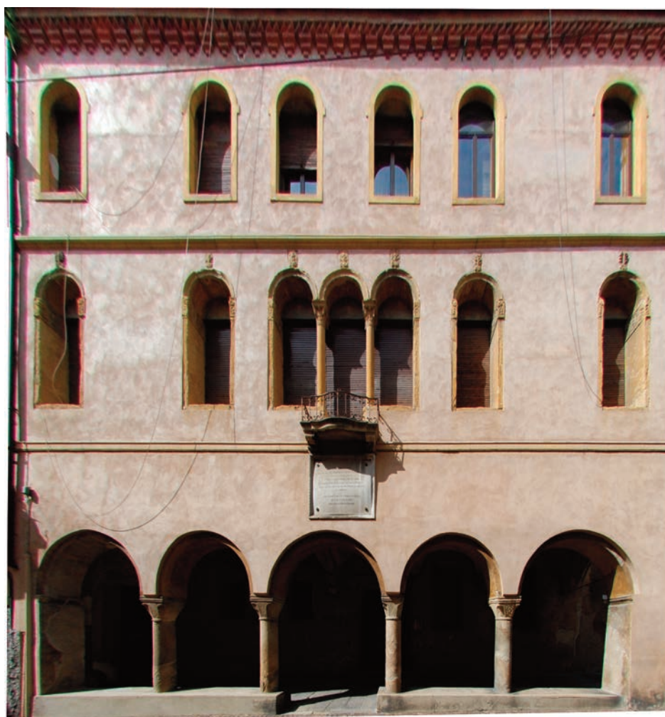
Fig. 8. Portico con parapetto di un palazzo in via Carlo Leoni.
