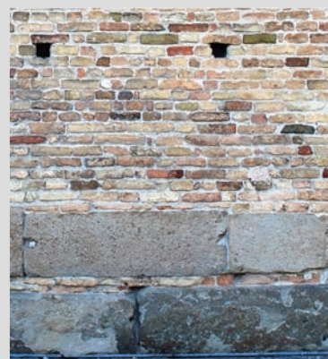
Fig. 9. Ognissanti: prospetto esterno est: particolare della tecnica muraria.
