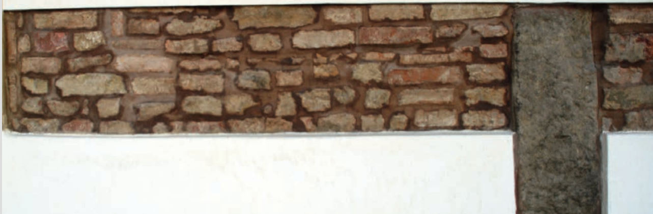
Fig. 41. San Pietro, prospetto esterno nord: particolare della tecnica muraria.
