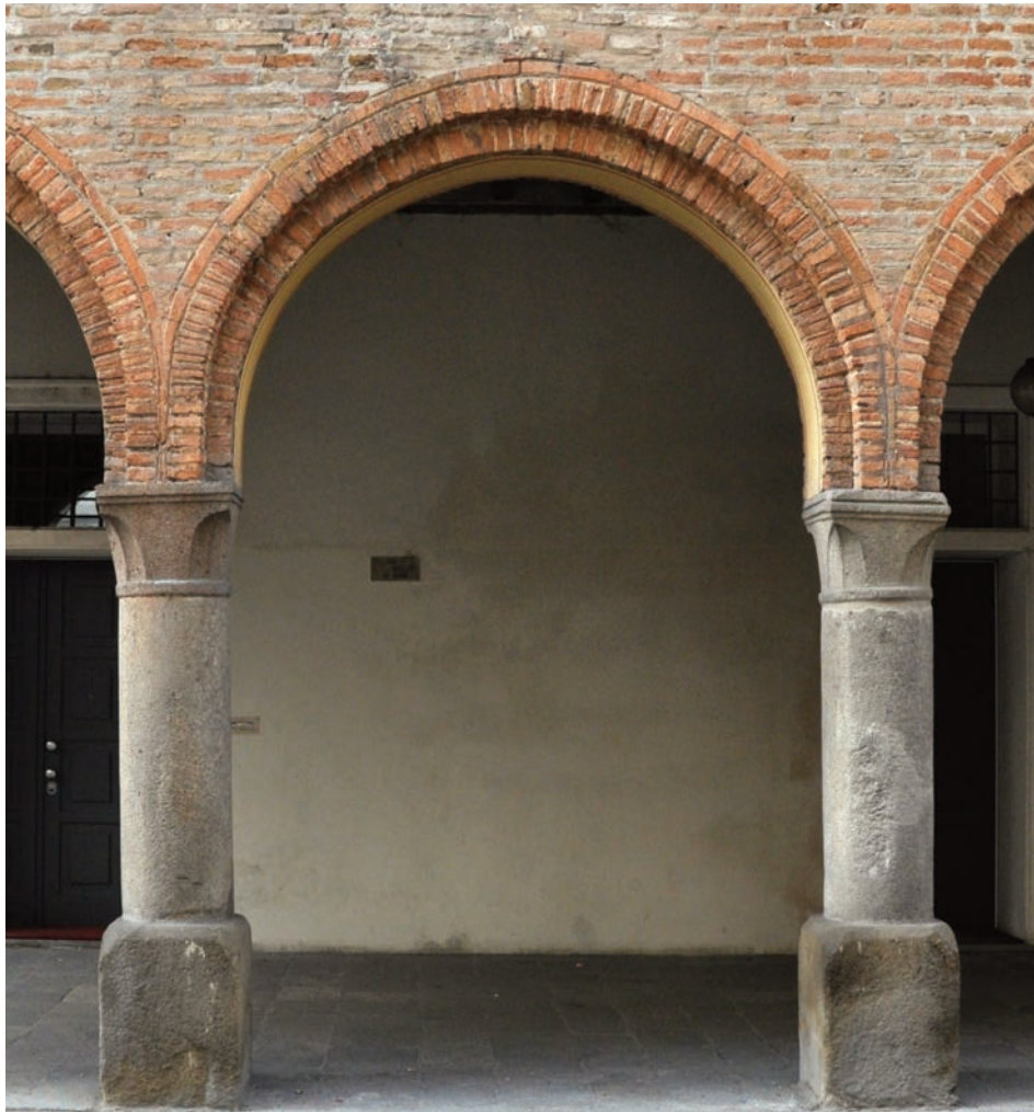
Fig. 7. Portici composti da due arcate poggianti su colonna centrale in via Dante 65.
