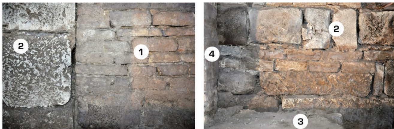
Fig. 15. Santa Sofia, lato nord della cripta: muratura in laterizi dell'emiciclo [1]; muro in pietra tra emiciclo e cripta [2]; fondazione [3]; pilastro [4] in appoggio a 2 e 3.
