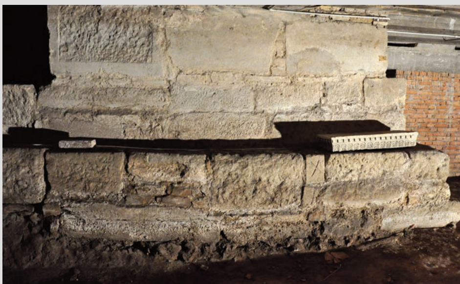
Fig. 23. Santa Sofia: particolare della fondazione a ovest della cripta.
