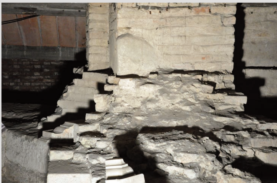
Fig. 27. Santa Sofia: pilastro costruito sull'interfaccia di demolizione dell'absidiola nord della cripta.
