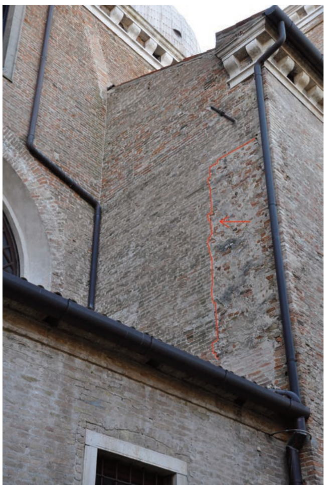
Fig. 34. Duomo, perimetrale nord: muratura in laterizi romani di reimpiego pertinente alla cattedrale romanica.
