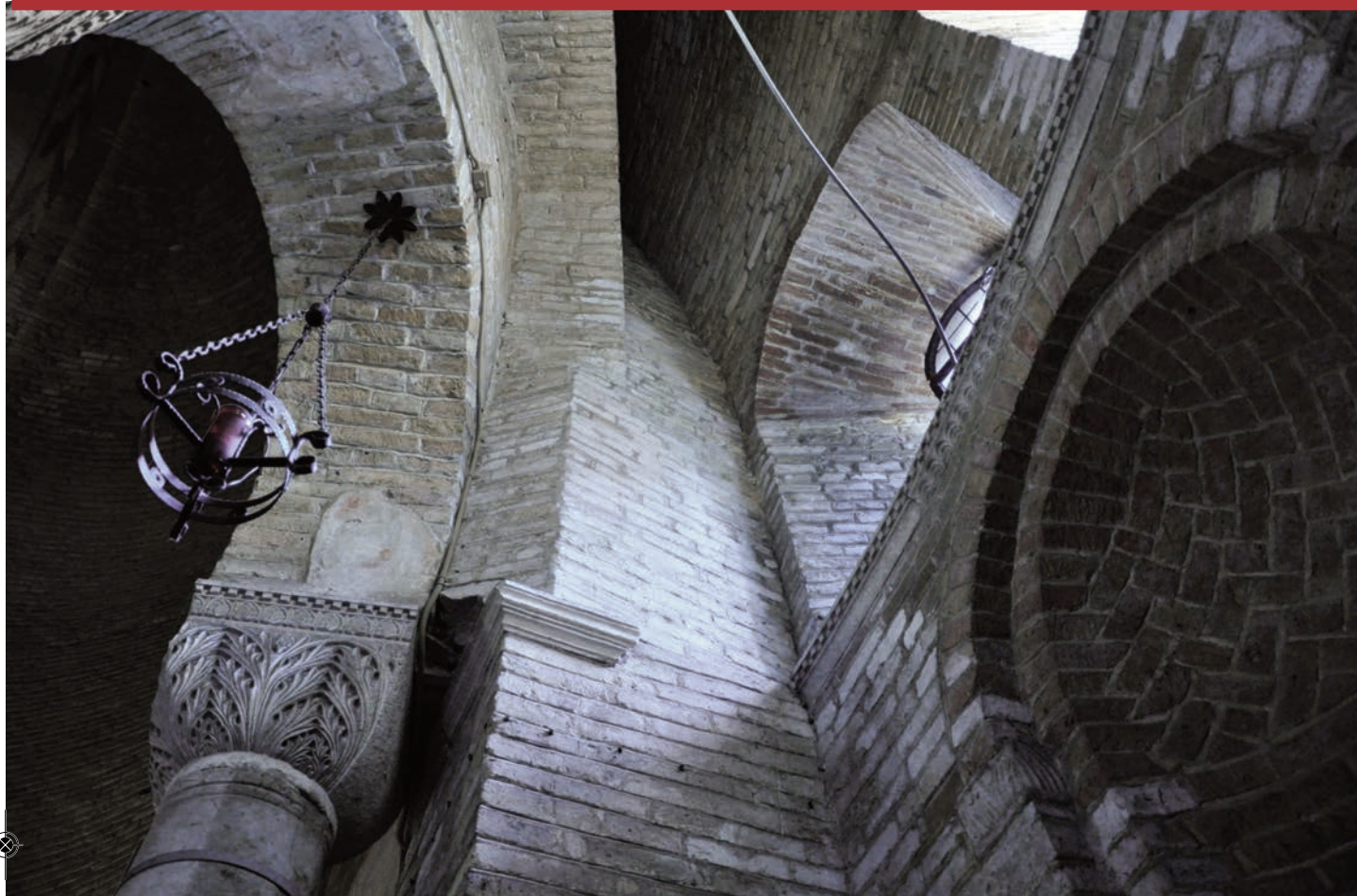
Fig. 25. Santa Sofia: muro di chiusura dell'ambulacro.
