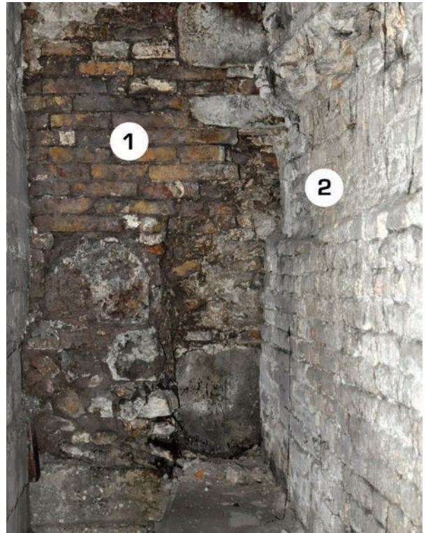
Fig. 17. Santa Sofia, trincea di drenaggio: muro est del transetto (1) tagliato dal muro d'ambito della cripta (2).
