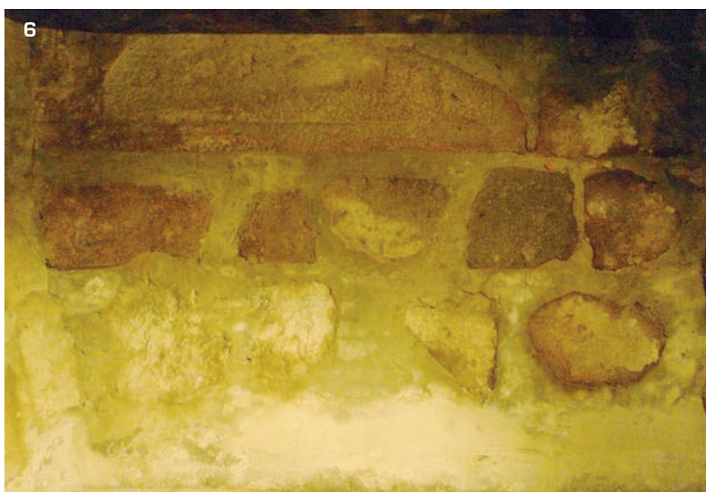
6. Paramento interno della fondazione della torre.
